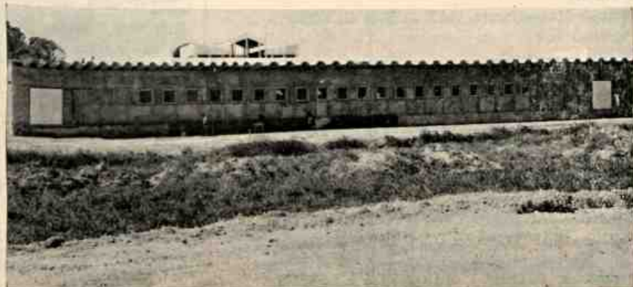
Fachada do Frigorífico em final de construção
