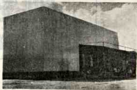
Câmara de estocagem p/2.000 t. em final de construção.
