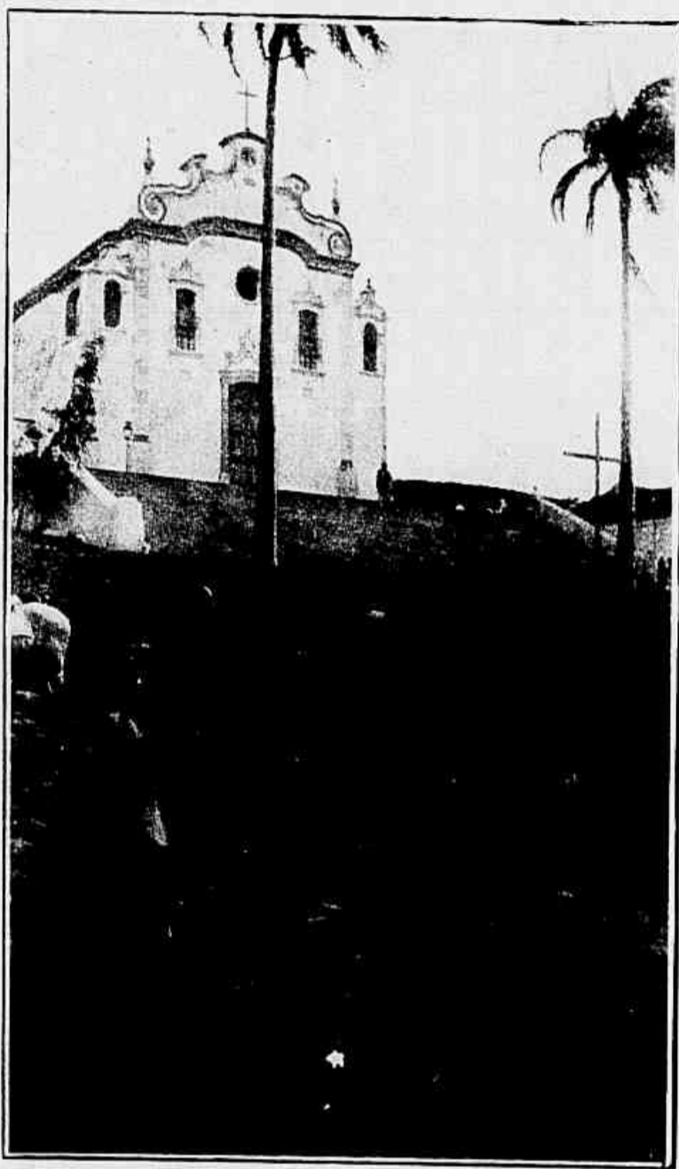
A igreja da villa de Fernando de Noronha, um dos mais puros barrócos de Pernambuco.
