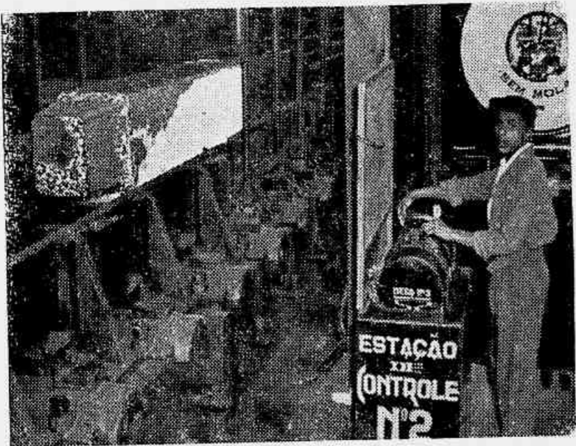
Um lingote de aço é pesado ao sair do forno de reaquecimento, de alta temperatura, passando a seguir, para o laminador desbastador
