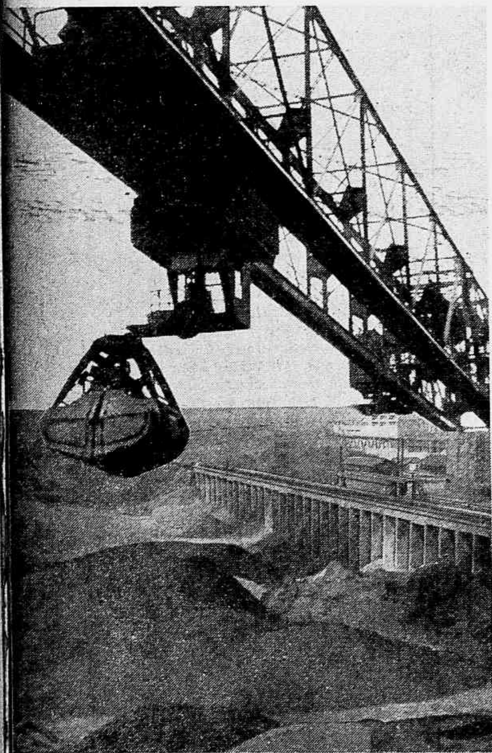
Vista parcial do grande depósito de carvão e minérios de ferro que são levados incessantemente à coqueria e ao Alto Forno por meio de enormes caçambas volantes pendentes da ponta metálica que se vê acima
