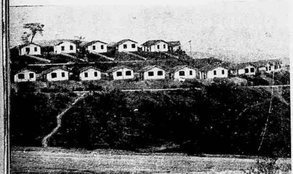
Uma visão distante do bairro "Monte Castelo" que está sendo construído, com todos os requisitos modernos de conforto e higiene, para residências de operários de pequenos recursos.
