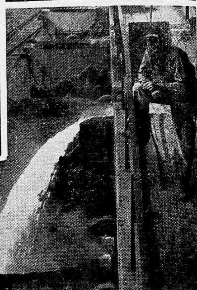
Um magnífico aspecto da corrida de ferro guza no Alto Forno. Ao lado, em cima, vê-se o ferro caindo em grandes panelas, nas quais é transportado para a Aciária. Em baixo, também ao lado, vê-se a escória do ferro, com que se pode fabricar o chamado cimento metalúrgico, caindo em vasilhames apropriados à sua condução
