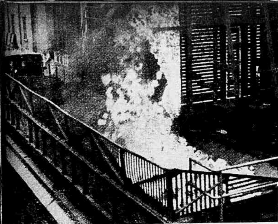
Esta foto fixa o instante em que se abre uma das 55 células da Coqueria, dando lugar à corrida de coque. Vê-se bem o coque desprender-se da célula e cair dentro de um carro de ferro que o leva para o lugar destinado ao seu resfriamento
