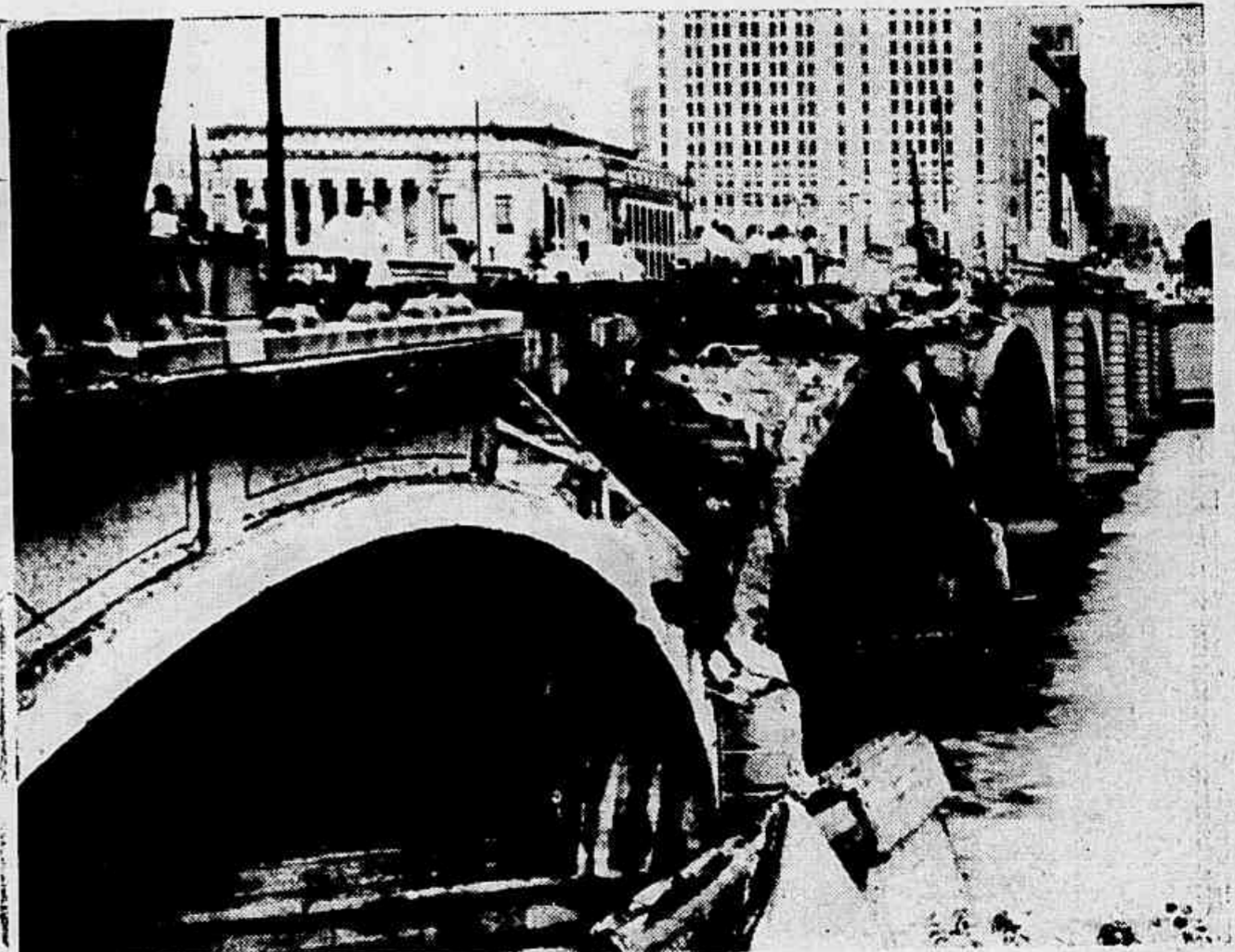
ESTRAGOS PROVOCADOS por um raio numa ponte de Columbus, Ohio, tendo morrido uma pessoa e várias outras arremessadas nas águas. Uma bomba não teria feito maiores danos e menos ruído.
