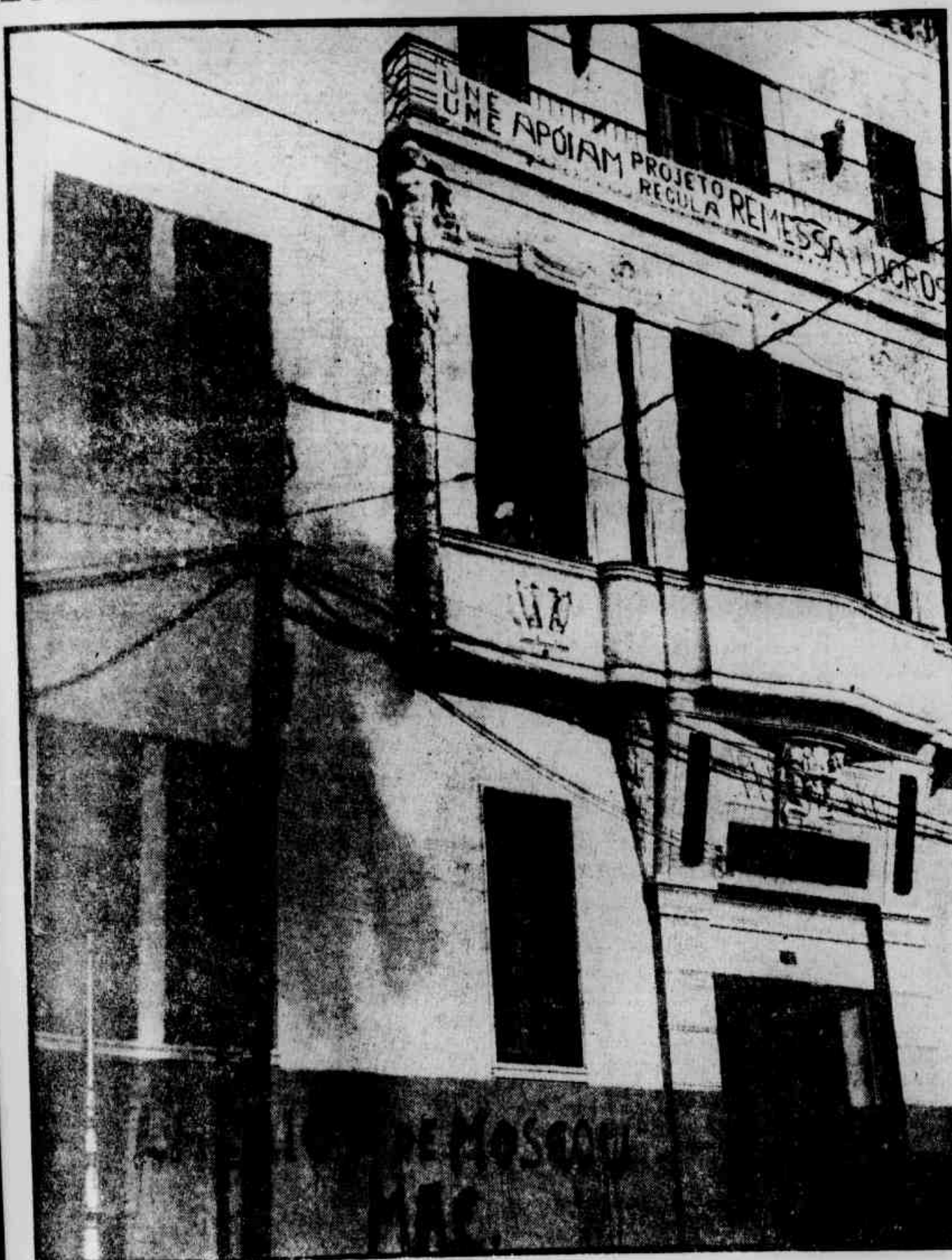
• Fachada da sede da UNE, metralhada e pizada pelos terroristas da MAC
