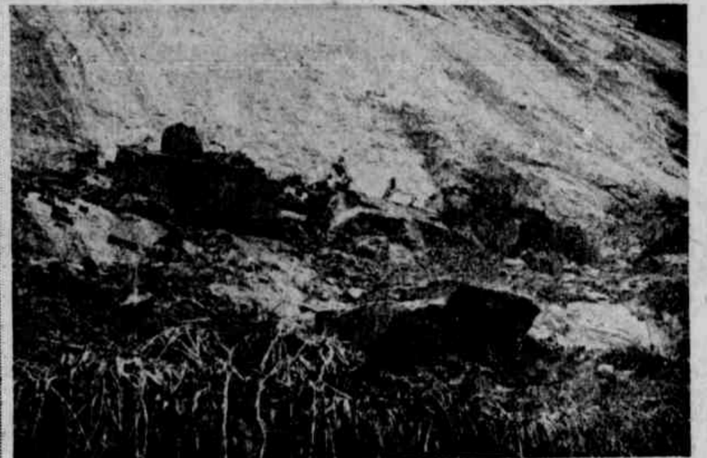
Esta é a pedreira existente na Rua Benjamin Batista, na Gávea, que causou destruição de resistência, e automóveis
