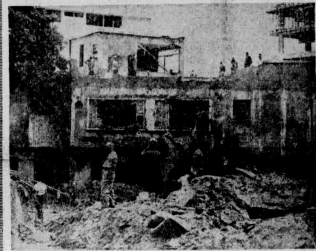
Ficou nest: estado a residência do ex-senador Ferreira de Sousa, na Rua Benjamin Batista, na Gávea, durante atropelada por centenas de pedras. Por verdadeiro milagre não morreu ninguém. Vai ser demolida nas próximas horas
