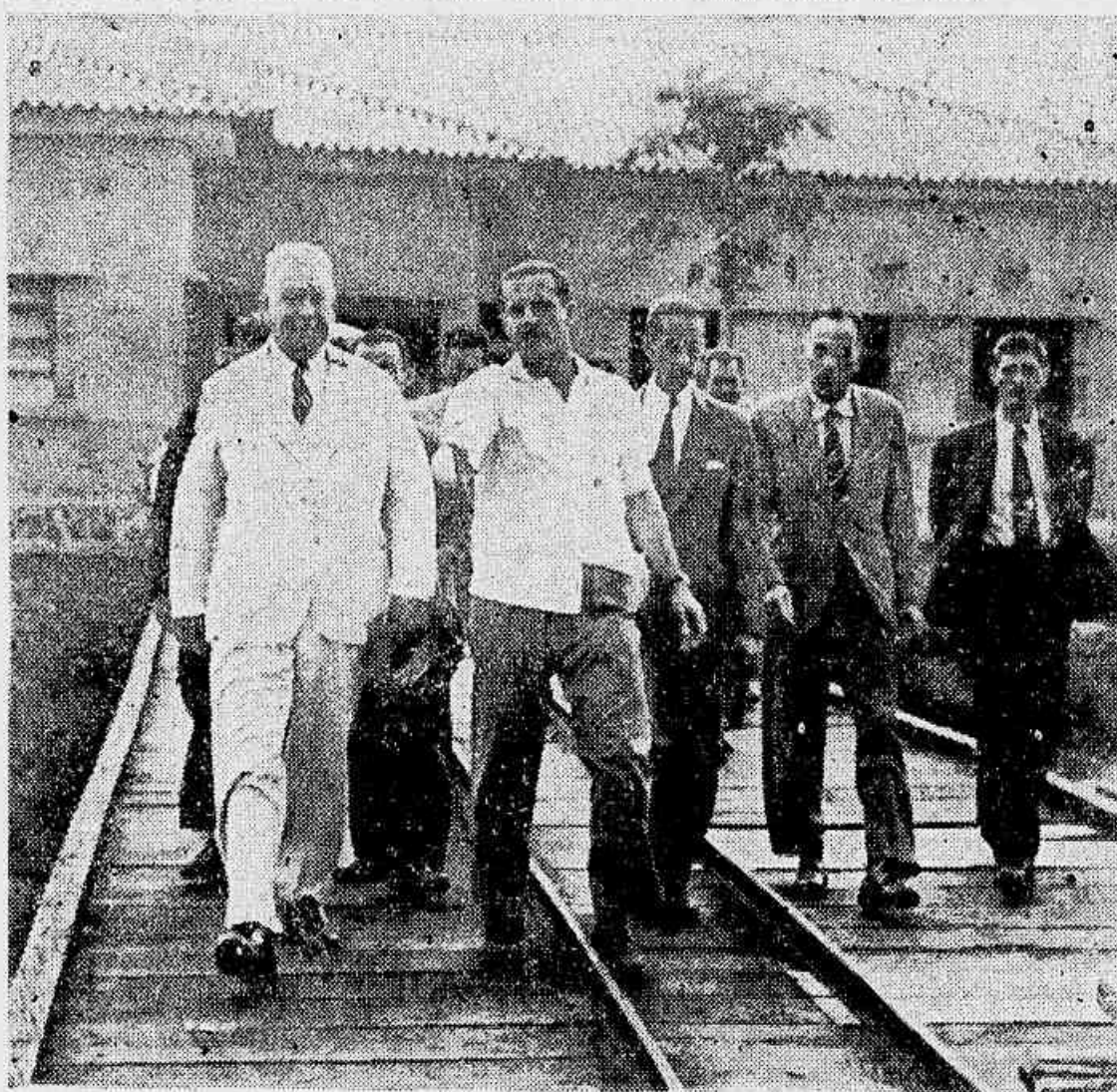
O Interventor Fernando Costa visitando, em fevereiro passado, o Entreposto de Pesca de Cananéia.
