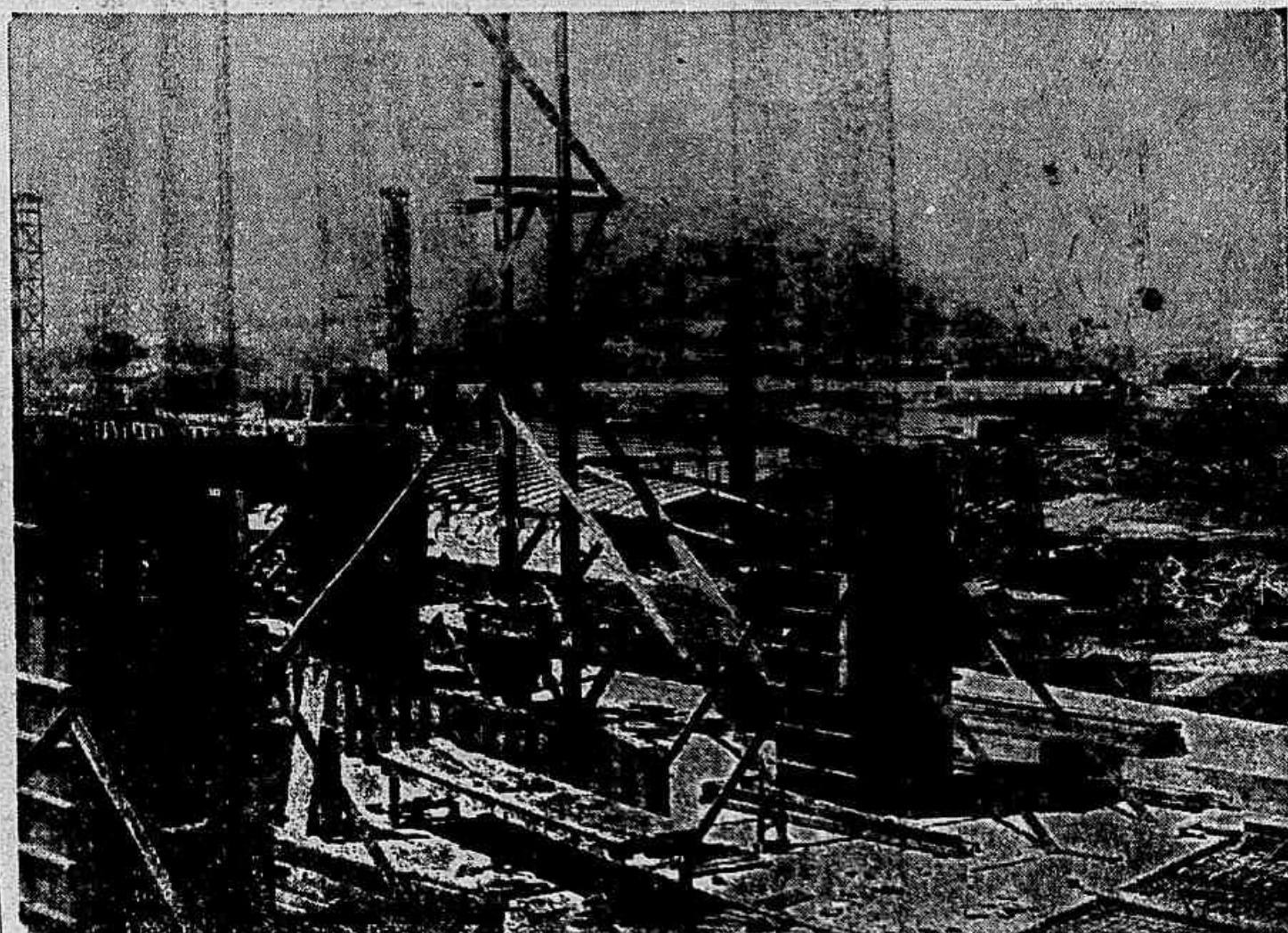
DO SONHO À REALIDADE: — Eis aí um aspecto das obras que estão sendo levadas a efeito para construção do Estádio Municipal. (Ler na 3.ª página)
