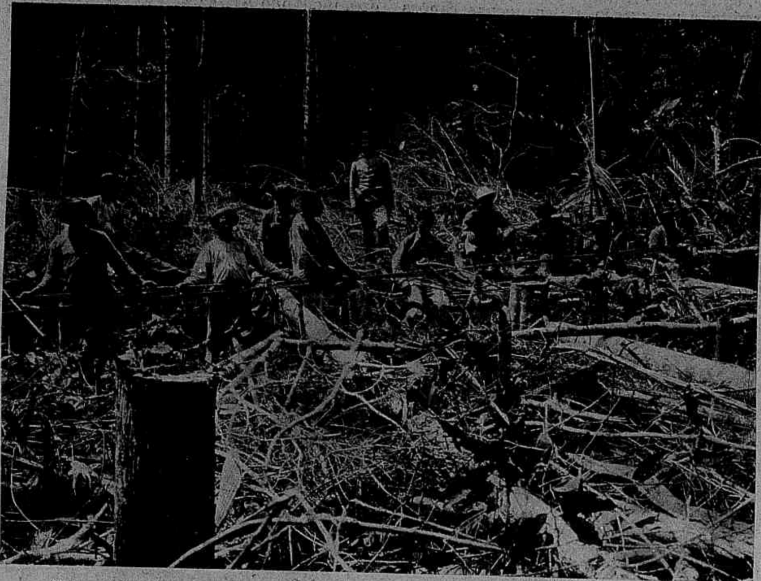
Esticamento de um fio telegraphico conductor, de 0m.005, pelo interior de uma floresta. Serviço da comissão Rondon.
