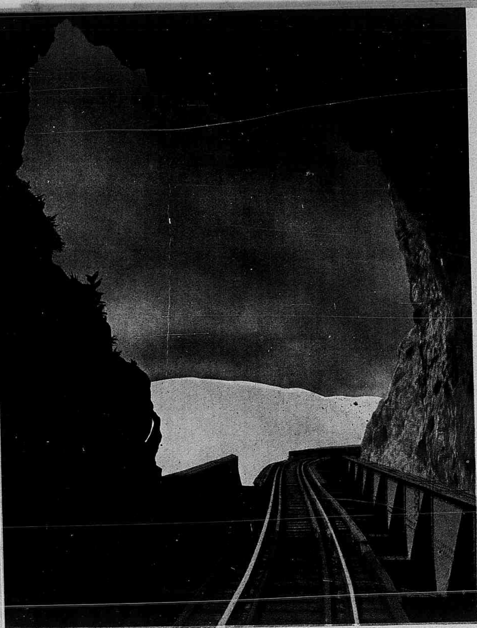
Tunel do Viaduto Carvalho
