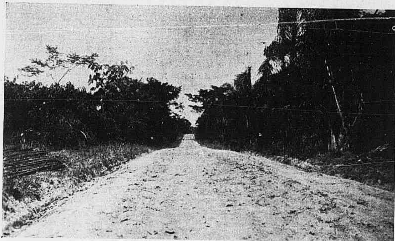
Estrada Rio Branco — Sena Madureira, construída sob a direção do Departamento de Produção.
