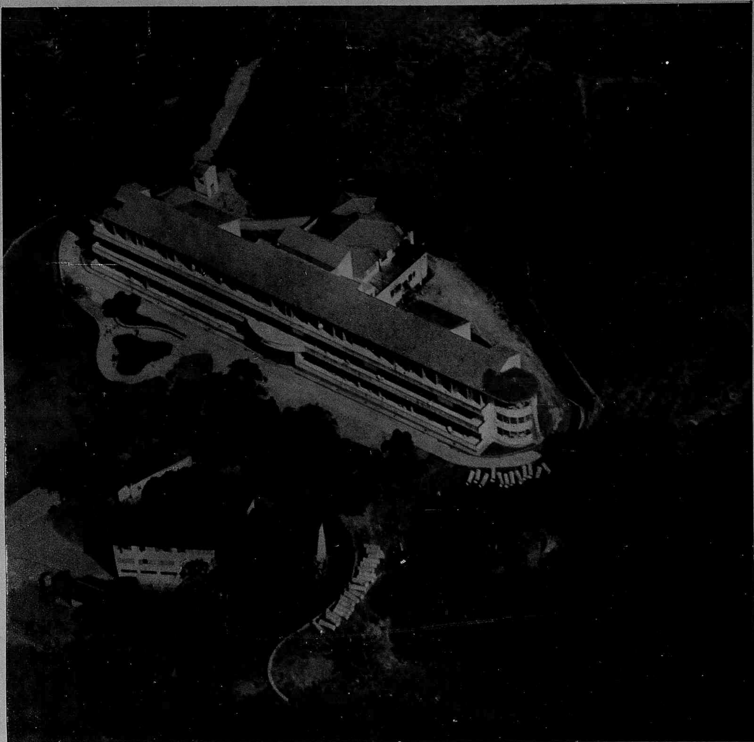
Vista aérea do Sanatório Cardoso Fontes de Jacarépaguá
