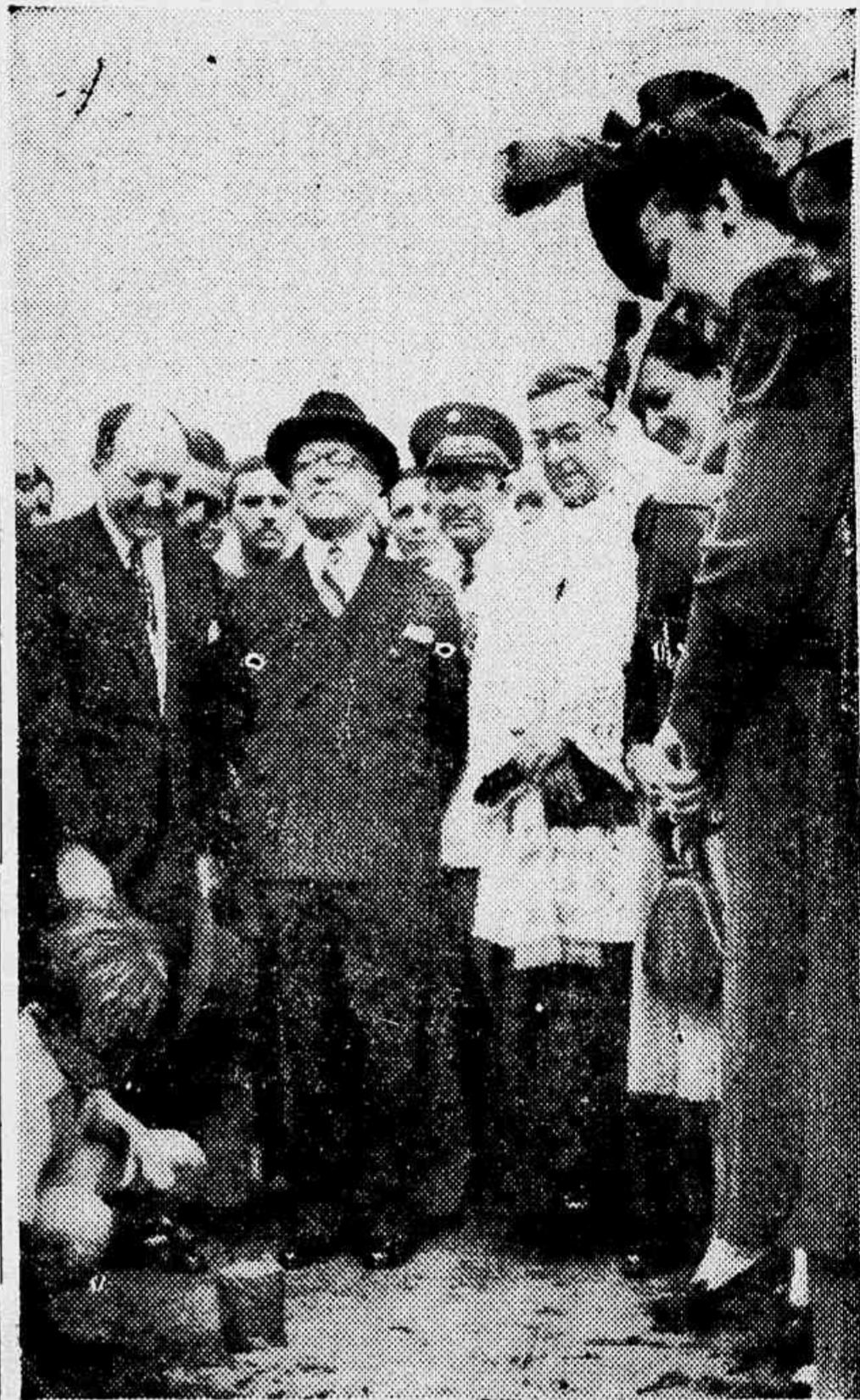
Durante a cerimonia de hontem, no local do futuro restaurante do Menor Operario: o menino José Silva colloca a primeira pá de cimento na pedra fundamental do edificio
