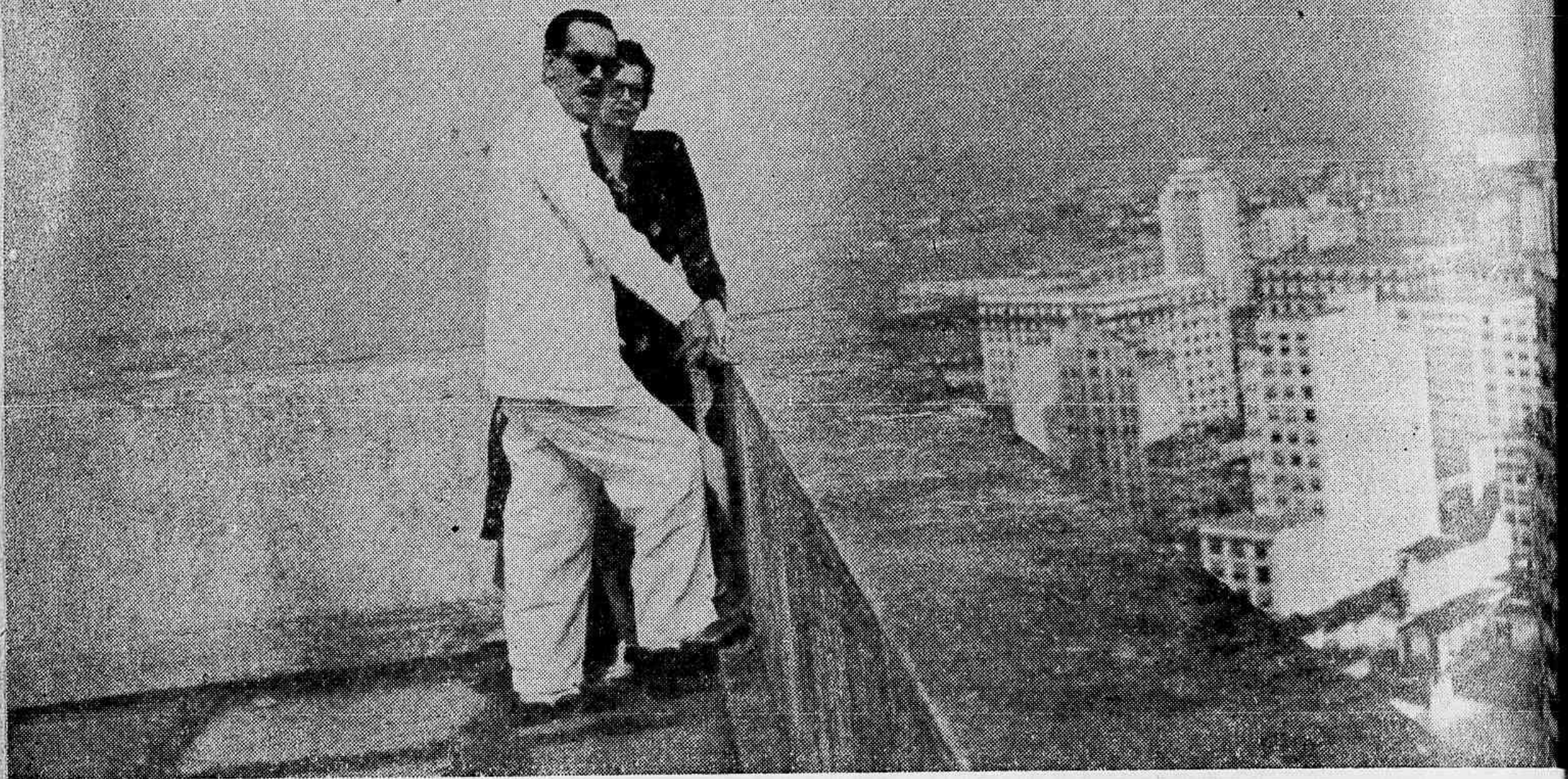
Paulo Gracindo e a nossa repórter discutem sobre o panorama da cidade que se descortina do terraço do edifício de "A Noite"
