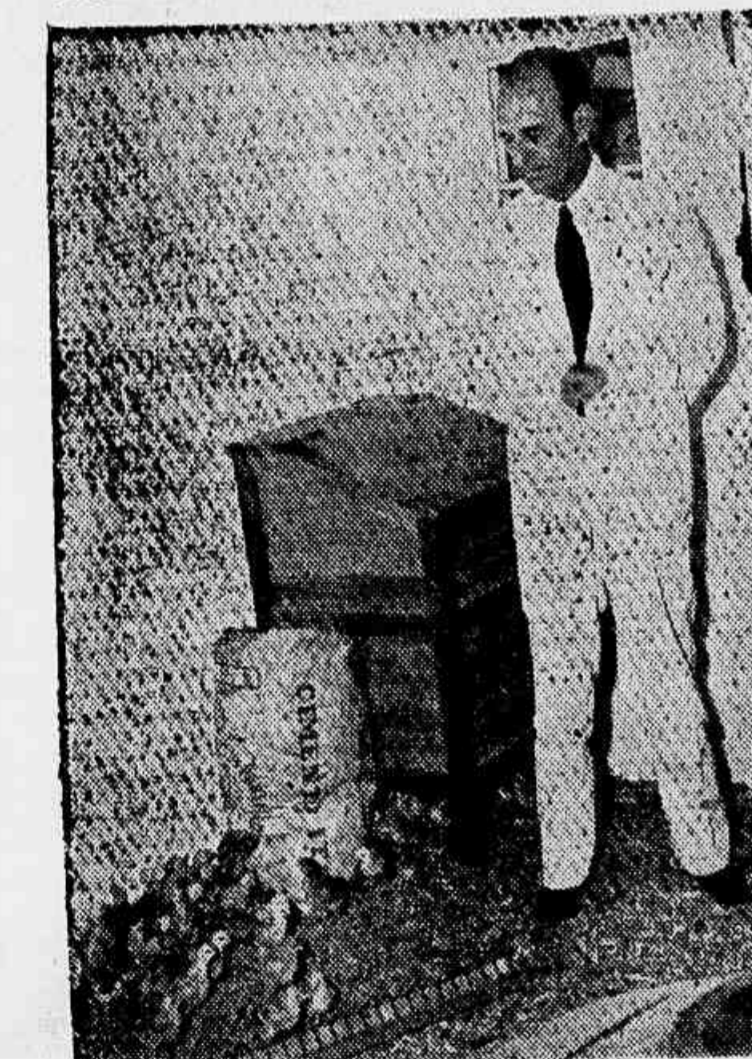
O ministro João Cleophas na Escola Agrícola de Muzambinho — O ministro da Agricultura visitou a Escola Agrícola de Muzambinho, do Ministério da Agricultura, localizada no sul do Estado de Minas Gerais, e a usina em construção para fornecimento de energia elétrica à referida cidade. Acompanhado do deputado Licurgo Leite, o ministro João Cleophas teve oportunidade de examinar o plantel de galinhas "legornas" da referida Escola, que ora fornece reprodutores aos aviadores da região. Também as plantações de café, milho e outras culturas foram inspeccionadas pelo titular da pasta da produção. Em Guaxupé, visitou o ministro da Agricultura o posto agropecuario da localidade, onde mantém o Ministério da Agricultura reprodutores de alta qualidade para atender aos criadores da região. Nos Torres, o ministro João Cleophas em companhia do deputado Licurgo Leite, inspeciona plantos da raça "legornas", e em visita às obras da usina de Muzambinho.
