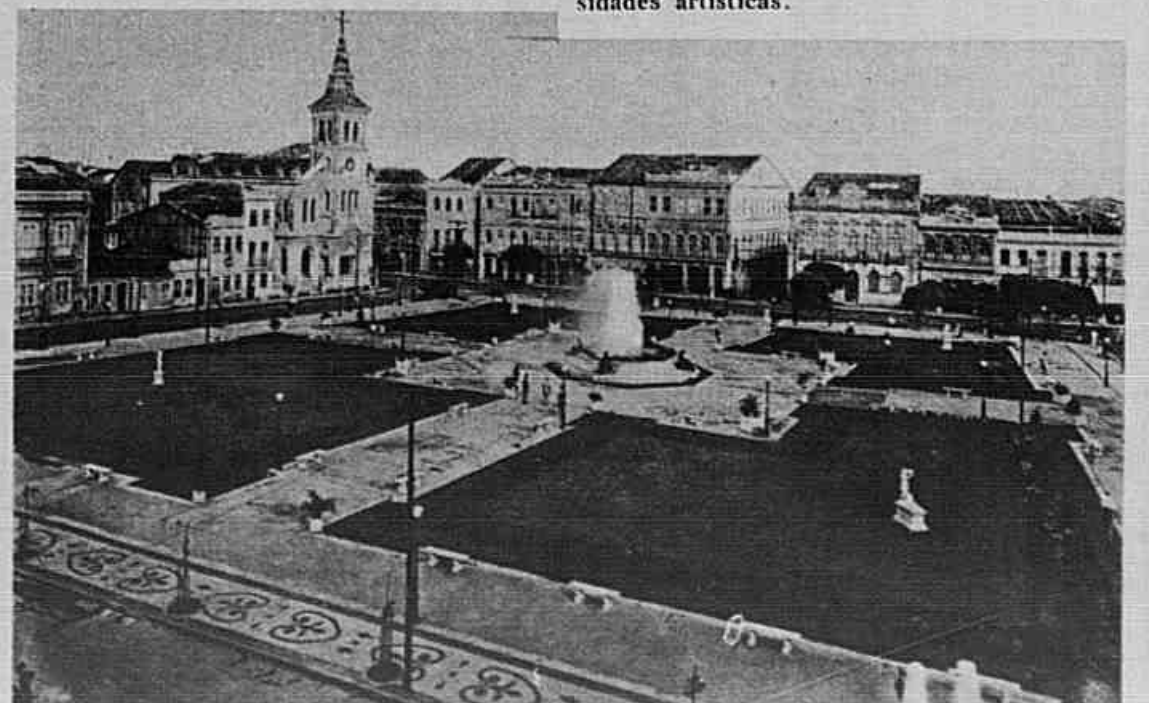
Aspecto da praça da Piedade, vendo-se a Igreja de São Bento.
