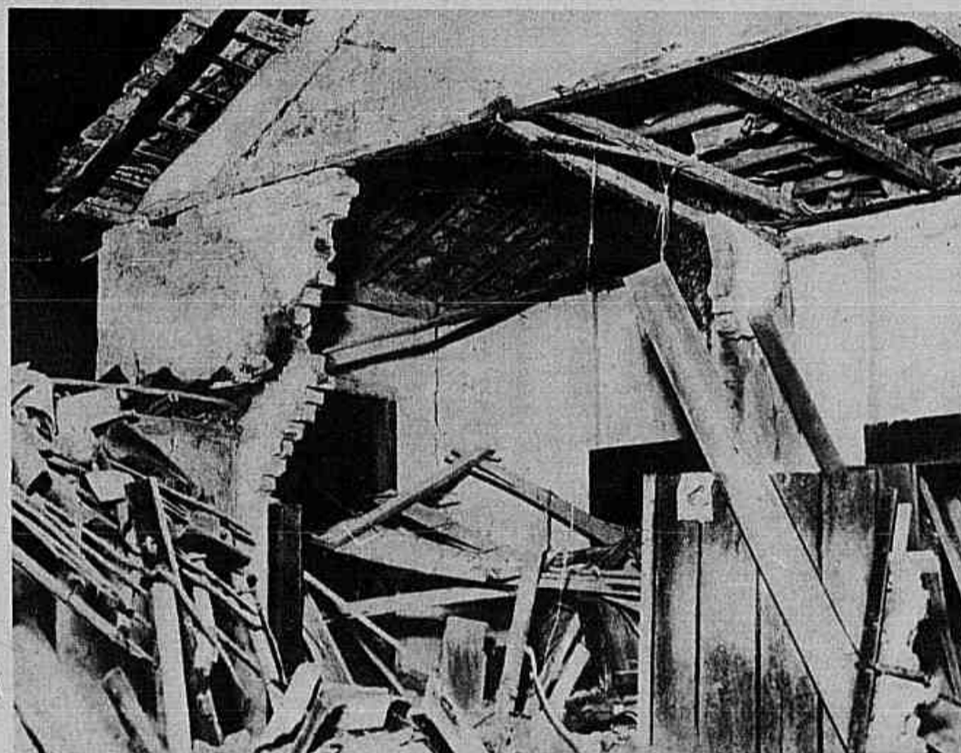
Detalhe da derrocada no prédio n. 42, da praia de São Bento.
