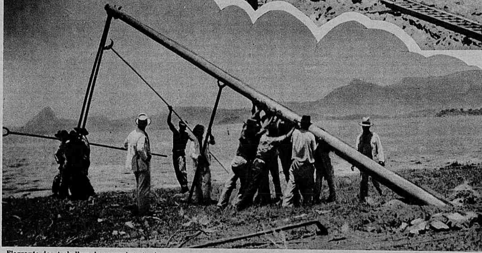
Flagrante dos trabalhos de reerguimento dos postes de iluminação, na praia de São Bento.
