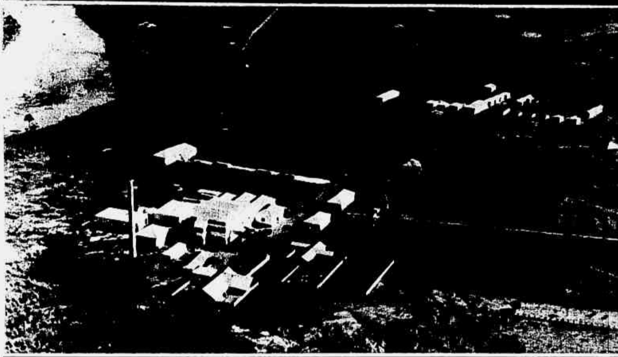
Vista aérea do Matadouro Industrial Ituiutaba. No segundo plano, à direita, a Vila "Misa", cuja construção já se iniciou e que se destina à residência do pessoal do grande estabelecimento.
