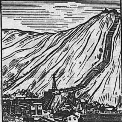
Em 1948, novo aumento da capacidade da Usina de Cubatão, com a instalação de mais um gerador de 65 000 quilowatts, elevou a capacidade do sistema para 823 000 quilowatts.
