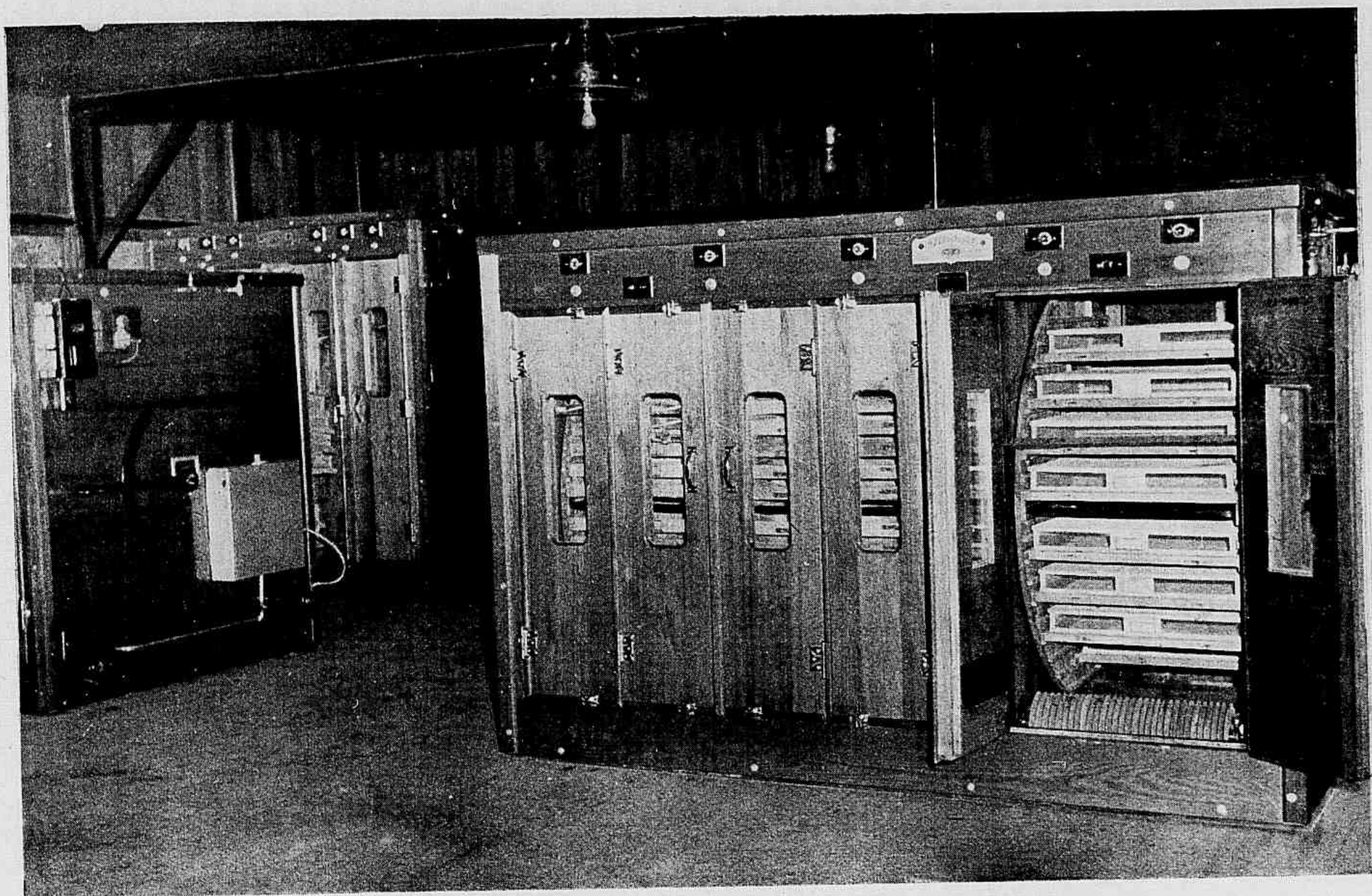
CHOCADORA DE CONSTRUÇÃO AMERICANA, COM CAPACIDADE PARA 11.000 OVOS, PROPRIEDADE DE UMA COOPERATIVA DO DISTRITO FEDERAL.
