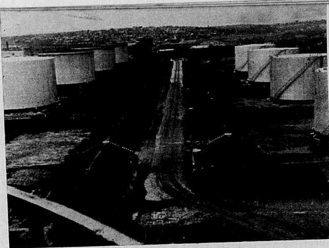
Oleoduto — Tanques de armazenagem no terminal de Utinga.
