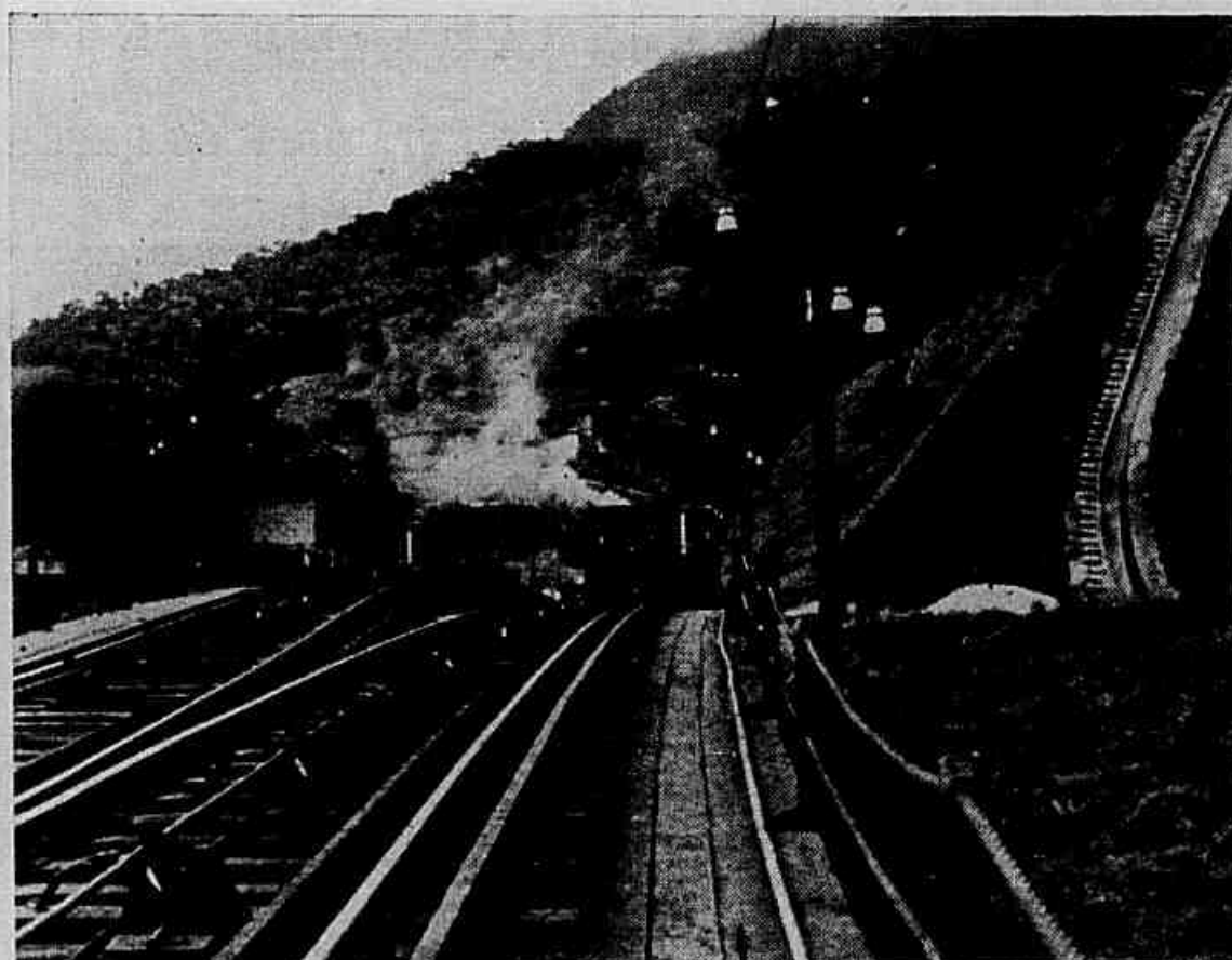
Modificações nos métodos de trabalho permitiram praticamente dobrar a capacidade dos velhos planos inclinados.
