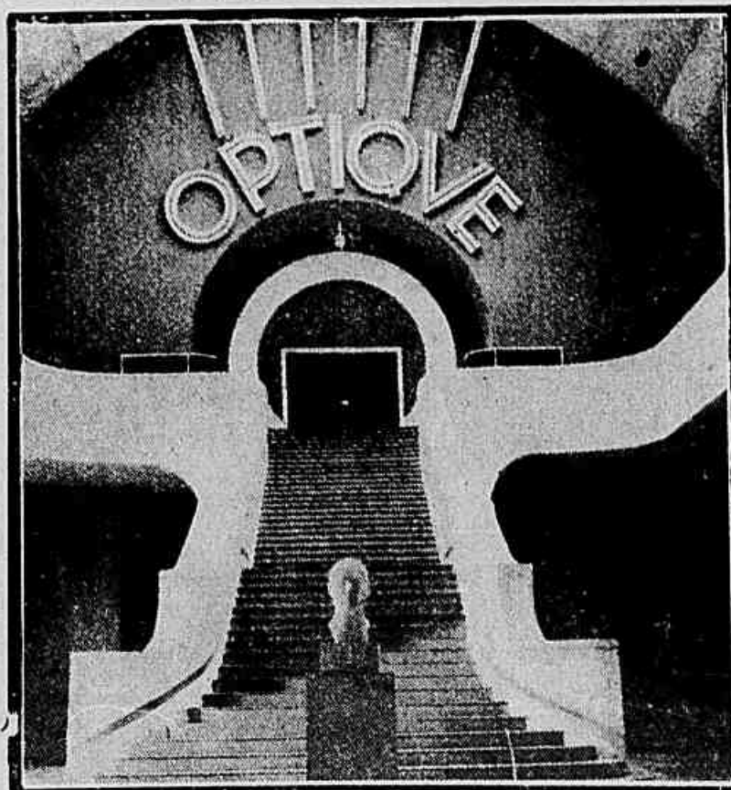
Os horrores da architectura moderna —Entrada do palacio da optica, na exposição de Paris.
