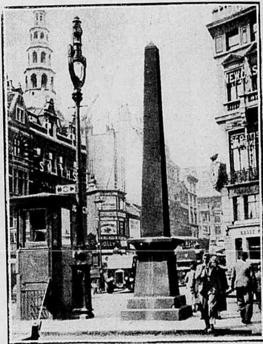
E ainda se falla no espirito pratico dos ingleses — Um aspecto de uma esquina de Ludgate Circus com um kiosque do serviço do tráfego e um obelisco. O publico e principalmente os chauffeurs não se cansam de reclamar, mas como o obelisco foi posto ahi para ficar diante da casa Robert Warthman a municipalidade não se resolve a retirá-lo.
