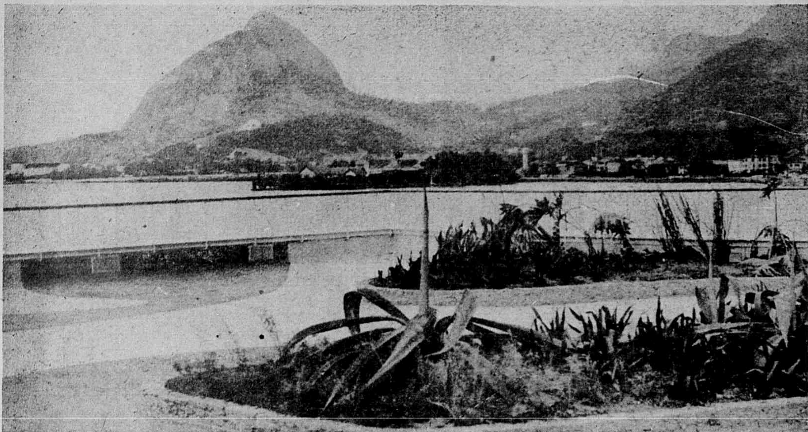
O jardim suspenso no terraço, da onde se descortina uma bela visão panorâmica da Lagoa
