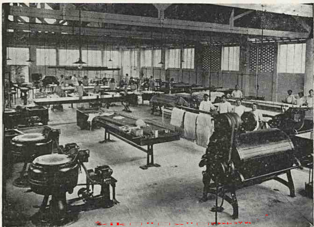
Aspecto de parte da grande sala de machinas.
