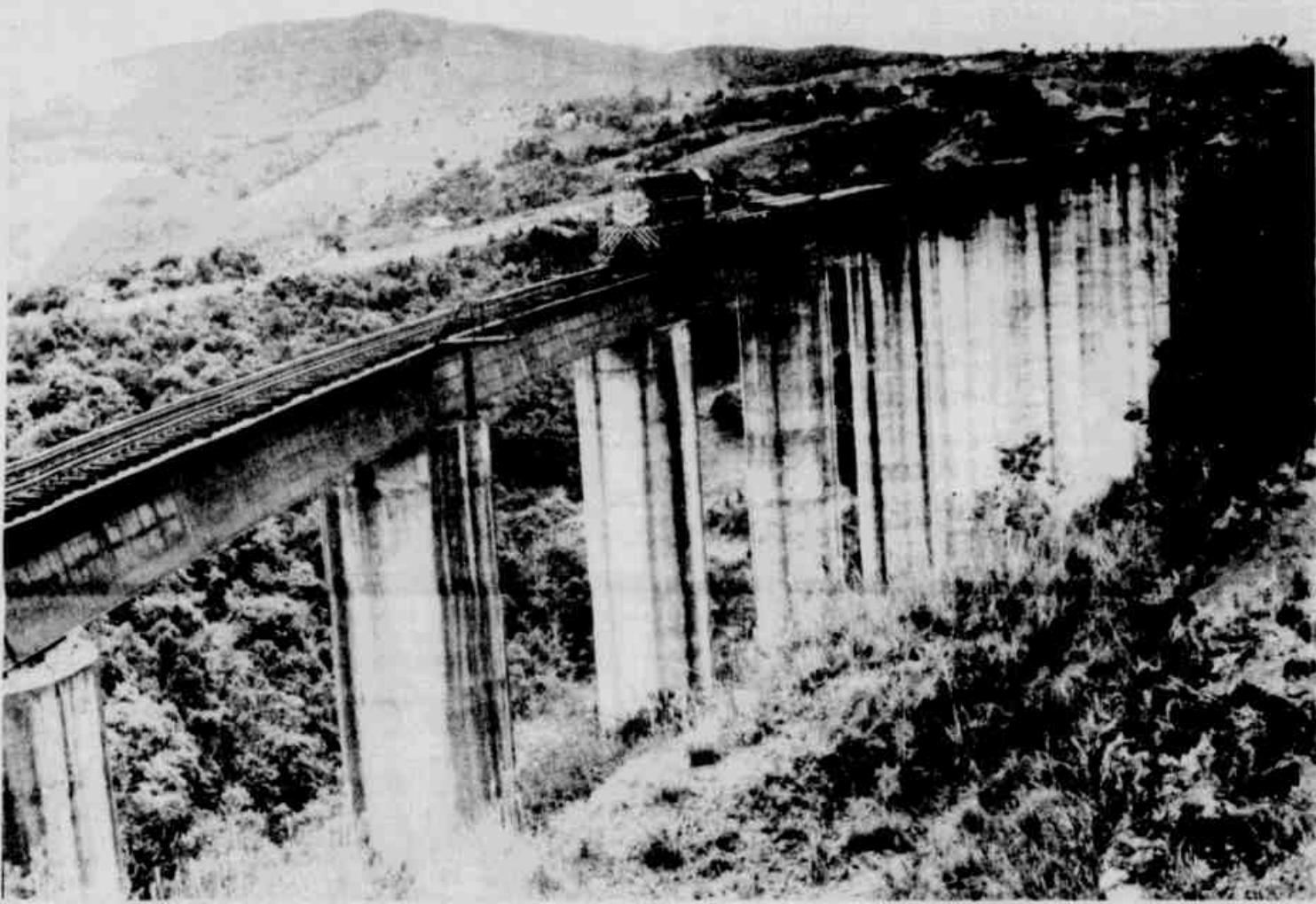
* "O viaduto Paraná, gigantesca obra de engenharia, é o símbolo da Estrada de Ferro Central do Paraná". (Arquivo R.F.F.S.A.)
