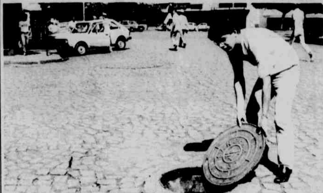
* Em 1985, foram implantadas 3.000 metros de esgotos sanitários.
