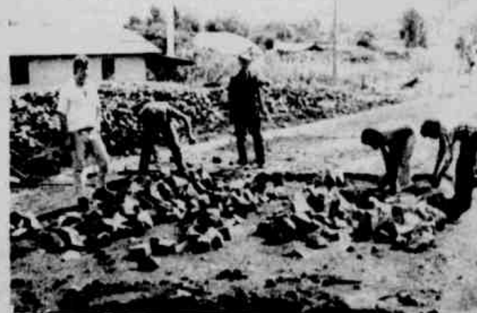
* Em execução, 40.000 m 2 de pavimentação com pedras irregulares.
