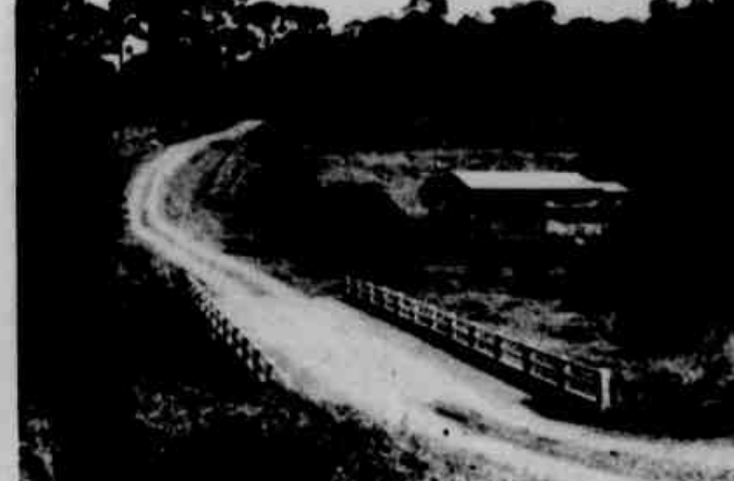
* Ponte em concreto sobre o rio Quietinho.
