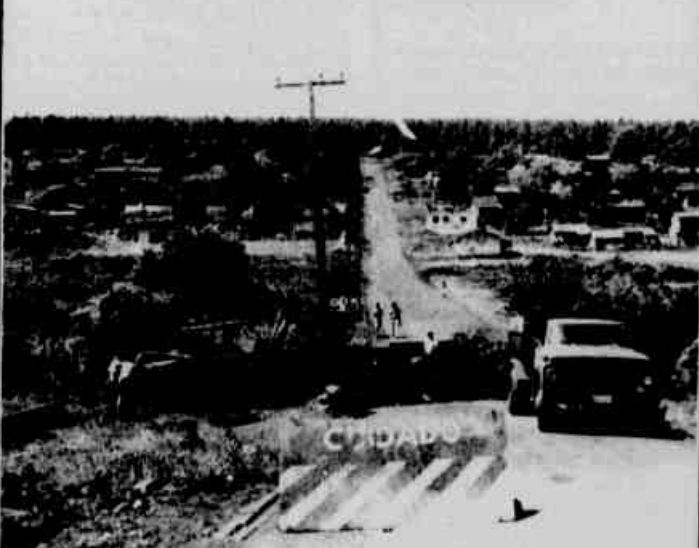
* As obras avançam em ritmo acelerado.
