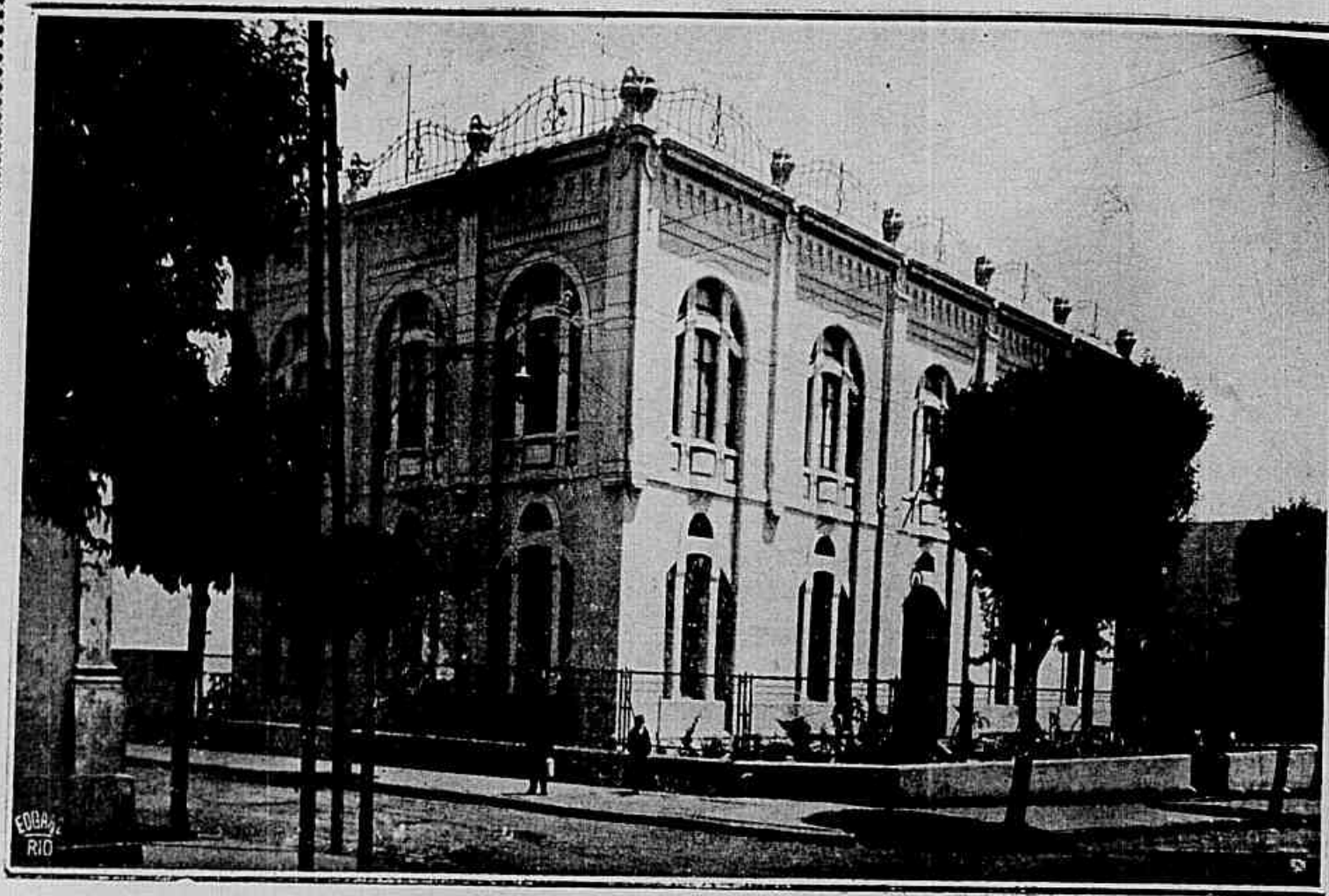
Edifício da Legião Brasileira, de Ribeirão Preto, o qual tem o maior salão de conferencias do Estado de S. Paulo.
