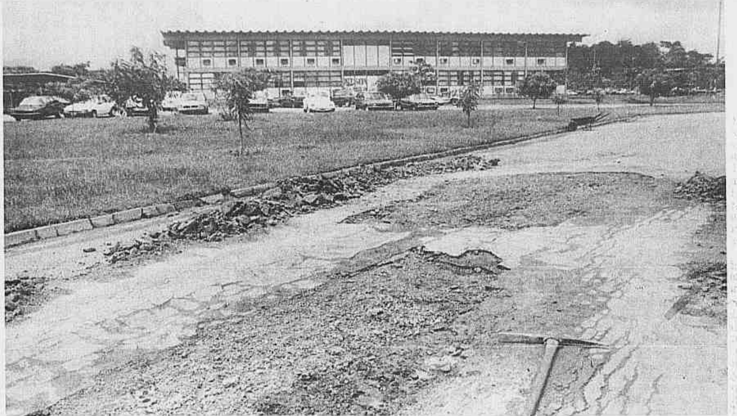
As obras já começaram e pretendem restaurar as ruínas do sistema viário
