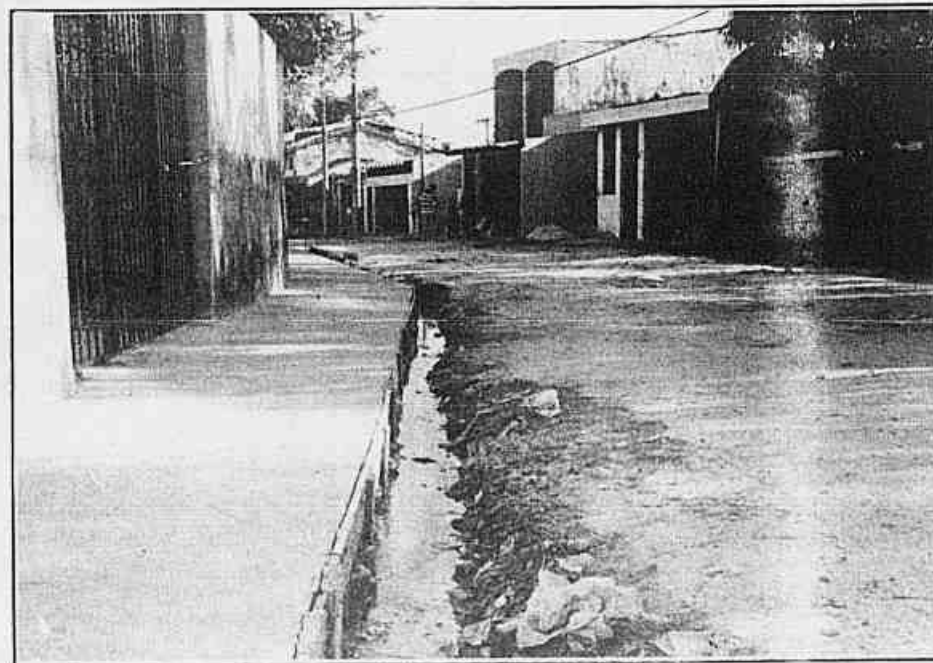
Sem um sistema de esgotos adequado, as valas permanecem a céu aberto
