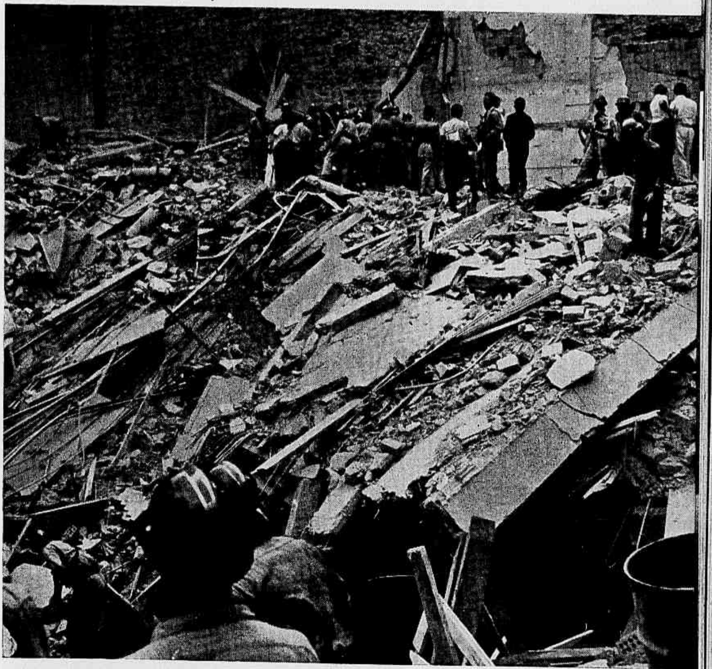
Restos do edifício da Caixa Econômica, à rua do Rosário. Meia hora antes disto acontecer engenheiros atestaram a segurança da obra. Inclusive um professor da Escola de Engenharia. O diabo é que prédio quando quer cair, não está ligando para desmoralizar ninguém.
